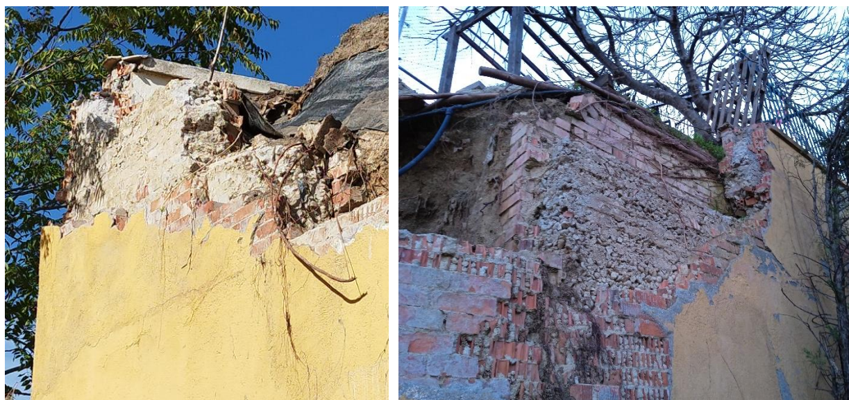
Figura 11. Detalles de la configuración del tramo superior del muro siniestrado.
