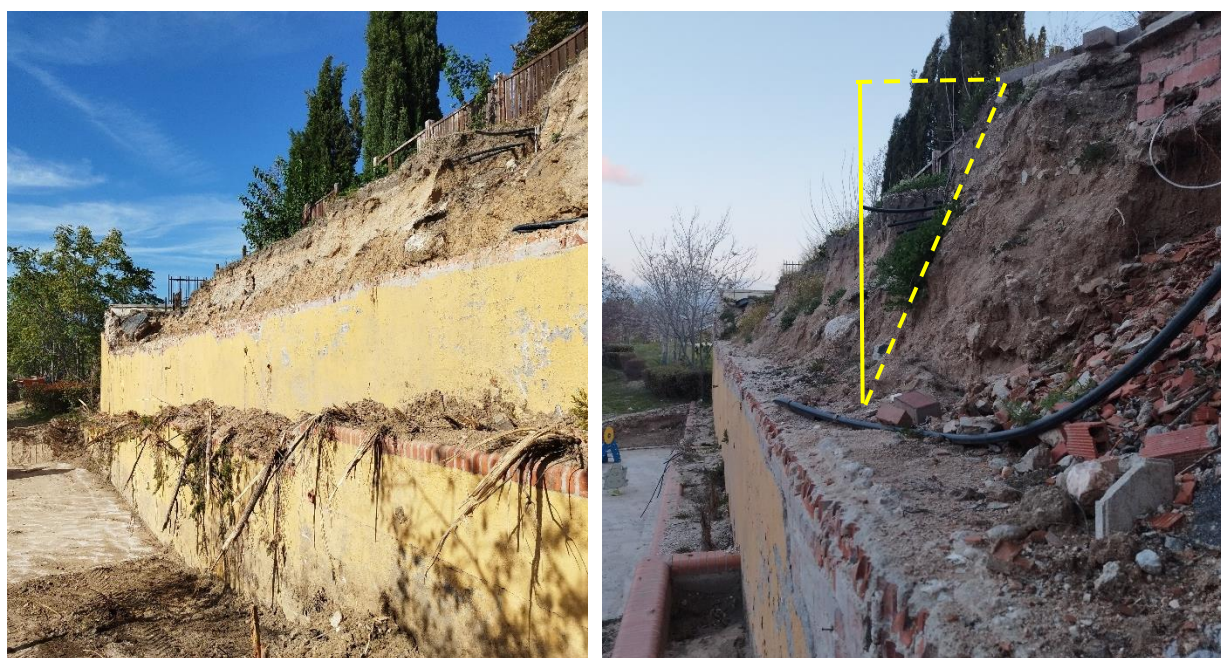
Figura 14. Detalle de la superficie de rotura y del terreno movilizado con el derrumbe.
