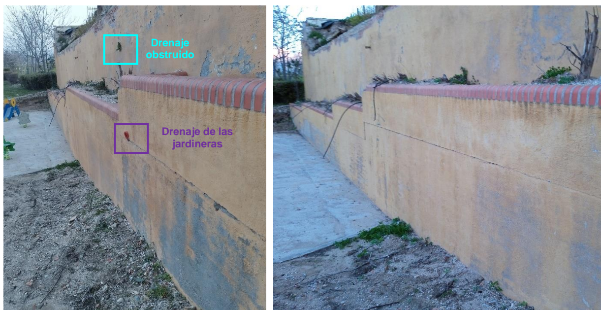
Figura 12. Detalles de la configuración del recrecido escalonado inferior del muro siniestrado y de su drenaje.
