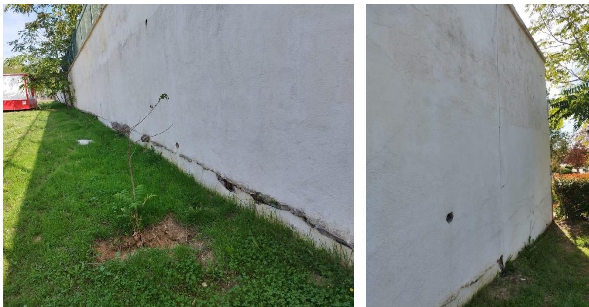
Figura 15. Anomalías observadas en el muro perpendicular al siniestrado.
